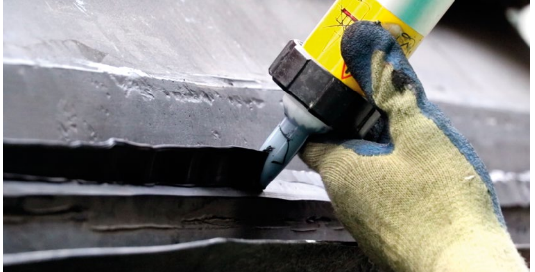
► Aplicación del adhesivo
